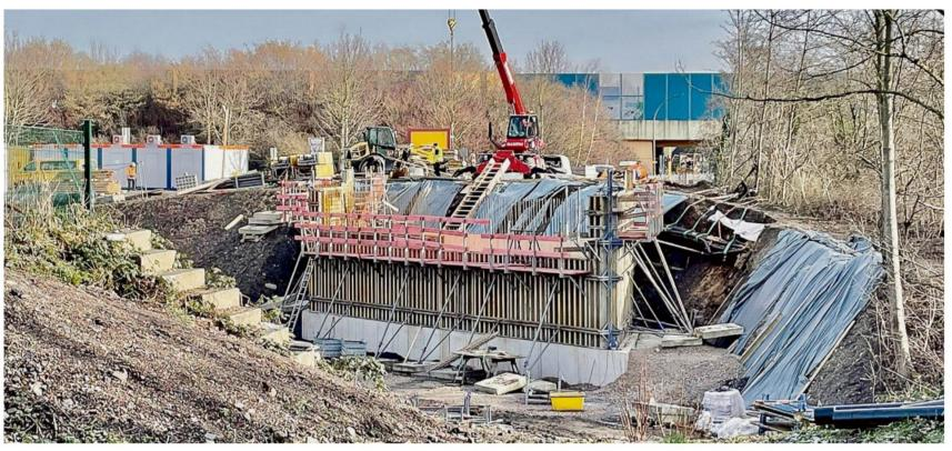
Gut zu erkennen sind die Arbeiten am Widerlager (Auflager) im östlichen Bereich der Baustelle. Im Hintergrund verläuft die B236.
