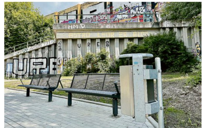
Bänke und Papierkörbe sind an dem neuen Radweg auch schon aufgestellt. Im Hintergrund ist die „verschollene“ Unterführung zu sehen, darüber die Lärmschutzwände der B236. FOTO JÖRG BAUERFELD
