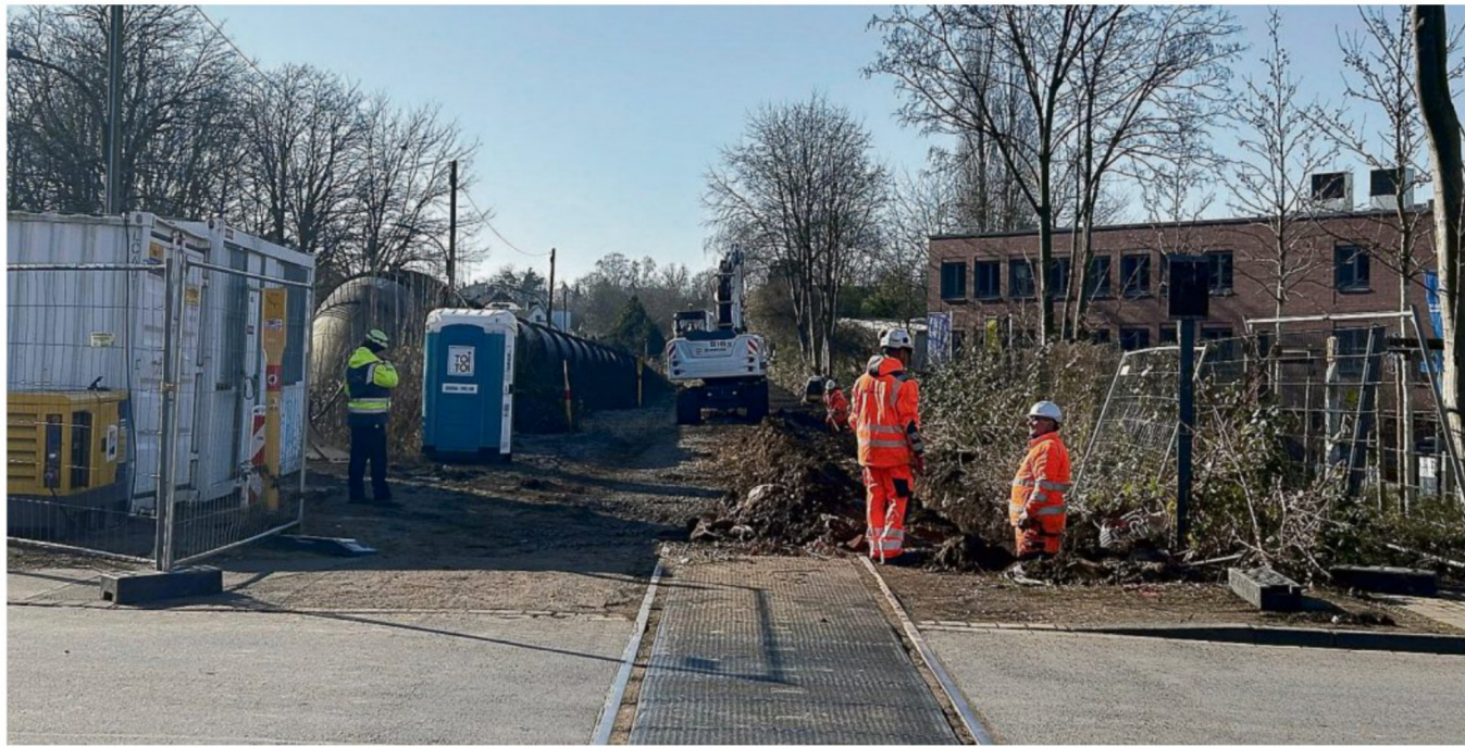
Noch liegen teilweise die alten Hoeschbahn-Gleise. Doch am ersten Bauabschnitt des Gartenstadt-Radwegs laufen die Arbeiten. FOTO OLIVER VOLMERICH
