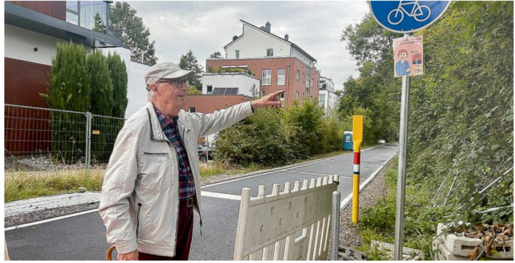
Auch am Überweg des Radwegs am Defdahl stehen (geöffnete) Bauzäune, wie Dieter Osbelt zeigt. FOTO OLIVER VOLMERICH
