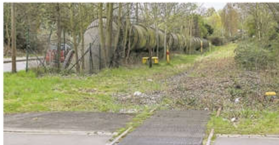
Die ehemalige Hoesch Bahntrasse soll zum besagten Gartenstadtradweg teilweise umgebaut werden.
