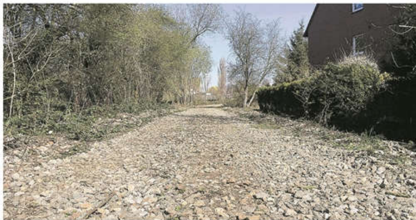
Noch liegen Schottersteine auf der Trasse der alten Hoeschbahn, aus der der Gartenstadt-Radweg werden soll.
